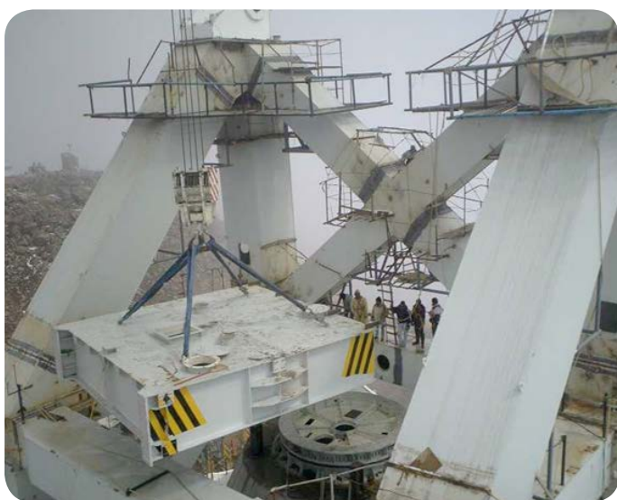
Imagen 2: Una vista del proceso de construcción del GTM.
