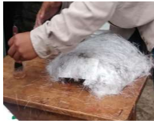
Figura 9. Colocación capa de fibra de vidrio
