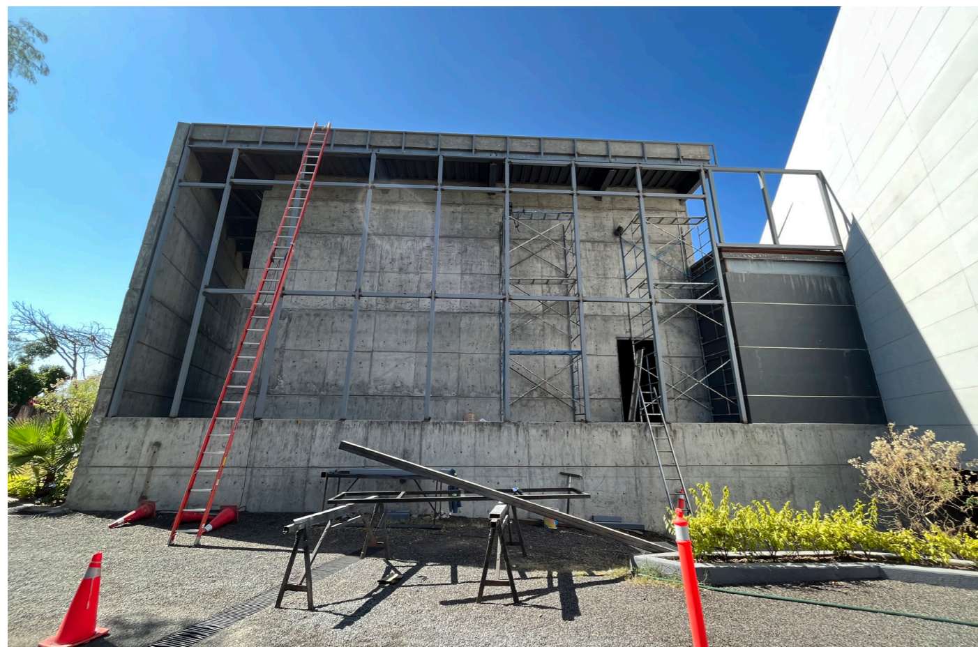
Trabajos en la fachada interna para protección del inmueble.
