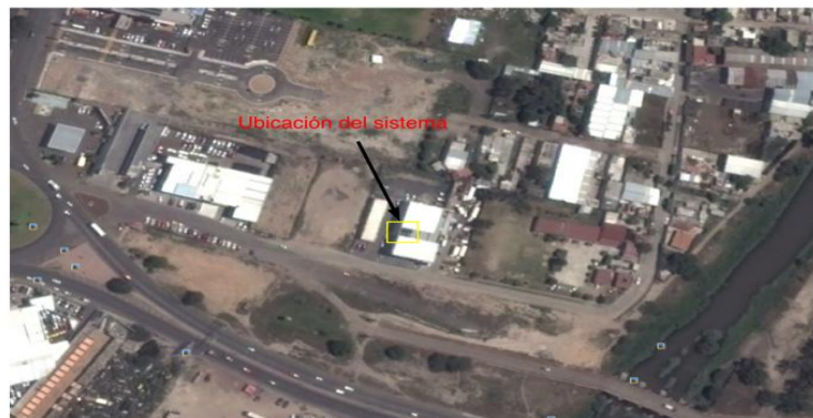
Figura 1. Ubicación sistema fotovoltaico de 4.5kW.
