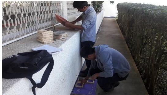
Figura no. 4. Elaboración del material de construcción.
